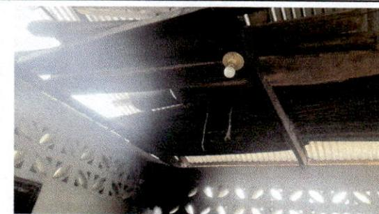
FOTO 4: SUSTITUCION DE SOPORTE DE MADERA POR METAL.
